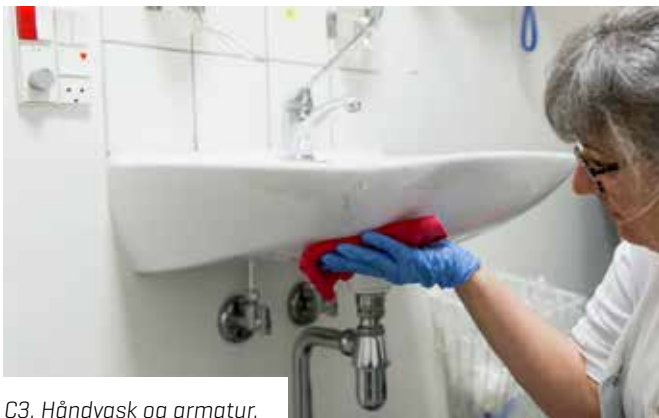
C3. Håndvask og armatur.
